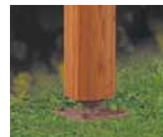
Ein Bodenabstand von 3 bis 5 cm schützt die Steherunterseite vor Feuchtigkeit.
