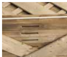
Sichtschutzelement - keine Staunässe, denn das Wasser kann durch Schlitz an der Rahmenunterseite ablaufen.
