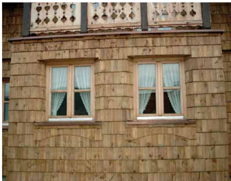
Holzschindeln Art.Nr. 4949 2-lagig für Wandverkleidung
