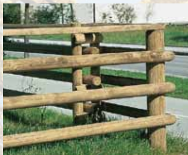
Rundholzzaun aus Palisaden und Halbrundhölzern
