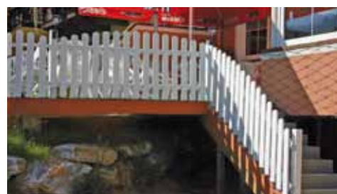
Terrassenabgrenzung - bauseits weiß lackiert
