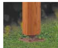
Ein Bodenabstand von 3 bis 5 cm schützt die Steherunterseite vor Feuchtigkeit.
