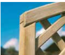
Die Stirnseiten der stehenden Rahmenteile sind durch den oberen Rahmen geschützt.
