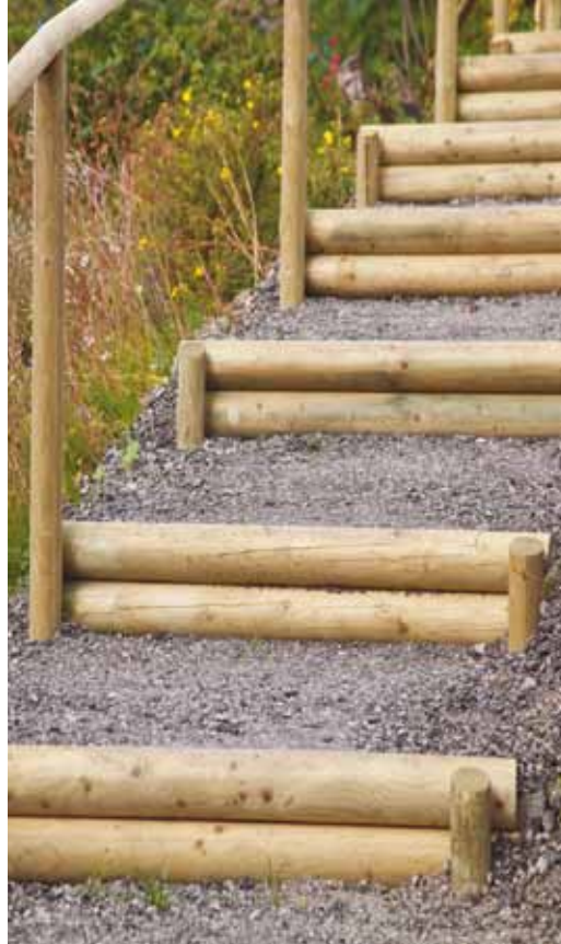
Rund- und Halbrundhölzer für den Treppenaufbau
